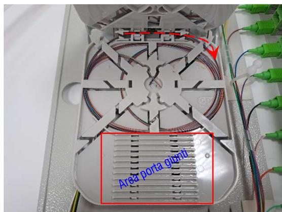
PARCHEGGIO FIBRE DEI PIGTAILS NEL MODULO DI GIUNZIONE.
